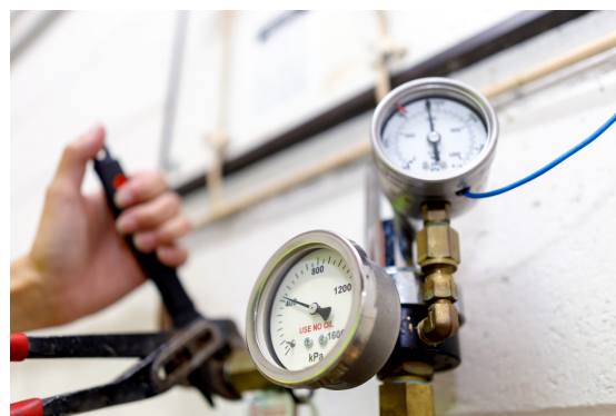
Melhorias na rede de gás
